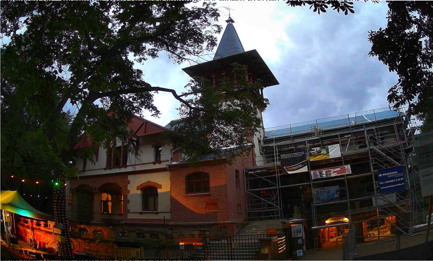
Foto vom 01. Juli 2020 (die Südfassade ist fertig).
