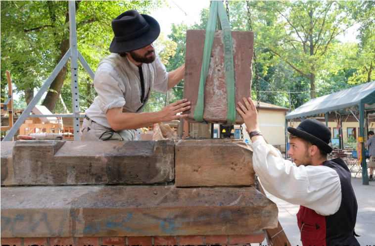
Die Steinblöcke werden mit Hilfe der Krananlage in die Höhe geholt. Die Arbeiter sind dabei sehr vorsichtig, um die Blöcke nicht zu beschädigen.
