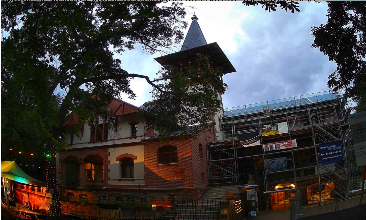
Foto vom 01. Juli 2020 (die Südfassade ist fertig).
