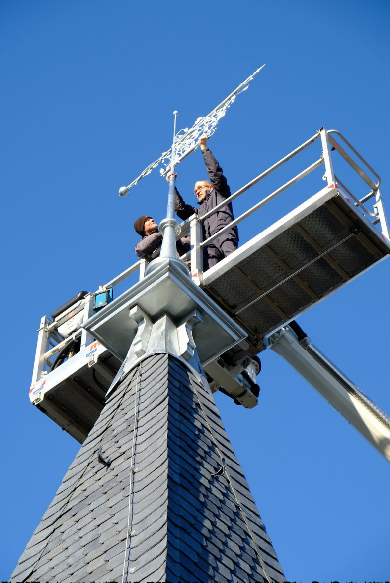
Bild 001: Die neue Spitze wird an der Dachspitze montiert.
