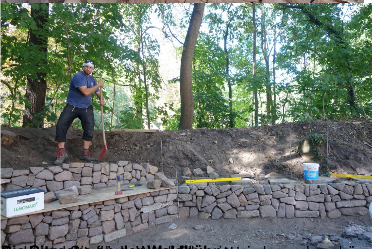
Die Steinblöcke werden mit Hilfe der Krananlage in die Höhe geholt. Einmal für den Stein, ein zweites Mal für den Mörtel.
