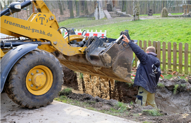
Das Bild zeigt die Sanierung des Peißnitzhauses im Peißnitzpark in Berlin. Ein gelber LKW ist dabei, die Fundamente des Hauses zu erneuern. Ein Arbeiter ist dabei, die Erde in die Grube zu schütten. Die Sanierung ist ein wichtiger Schritt, um das Peißnitzhaus zu erhalten und es wieder für die Öffentlichkeit zugänglich zu machen.
